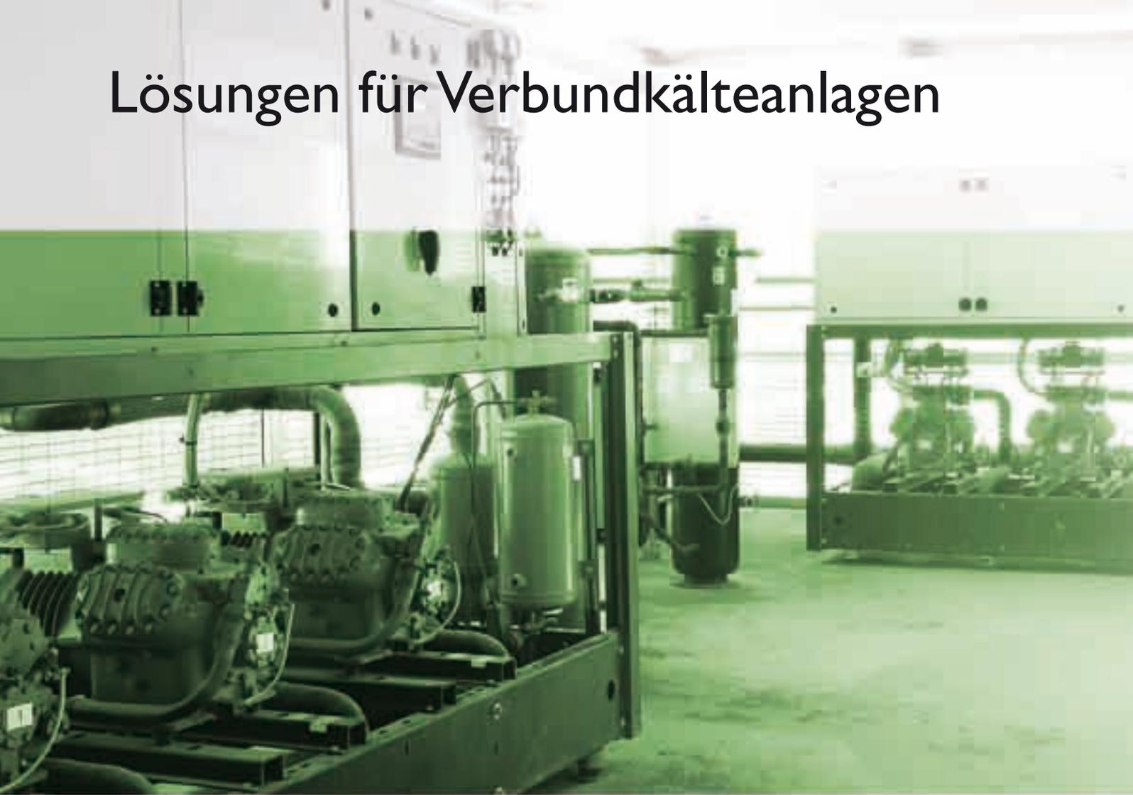
Die Verbundkälteanlage ist das wichtigste und komplexeste elektromechanische Organ eines Kühlsystems: von ihr hängt die Kälteleistung aller Kühlstellen und Verarbeitungsräume in der Lebensmittellagerung ab.
